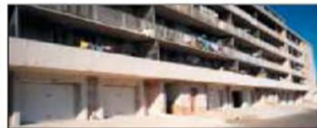
Réduction de la vulnérabilité structurelle par changement d'usage du rez-de-chaussée inondable
