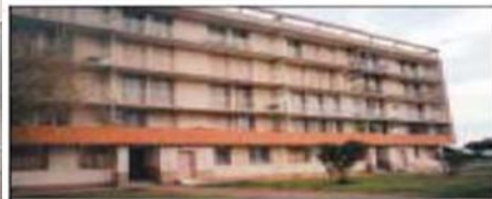
Réduction de la vulnérabilité structurelle par changement d'usage du rez-de-chaussée inondable
